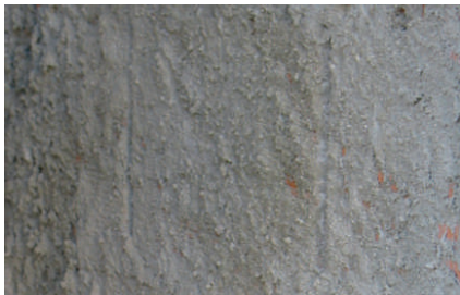
Suporte com Argamassa de Chapisco
