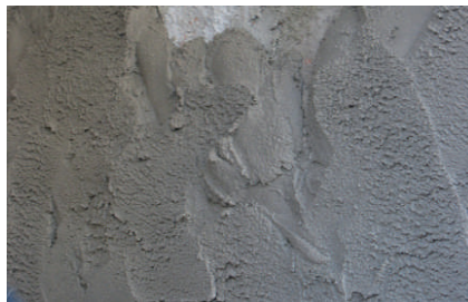
Aplicação de RHP Manual Exterior
